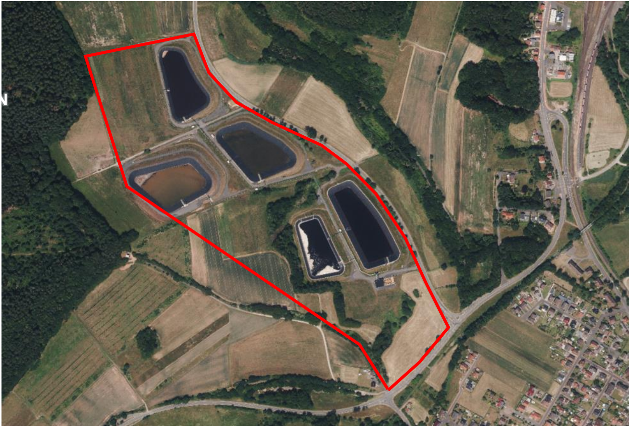
Abb. 2: Luftbild des im Regionalplan Nordhessen 2009 für Heringen (Werra) ausgewiesenen ‚Vorranggebiet Industrie und Gewerbe Planung‘ (rot umrandet) mit darauf zu erkennenden Anlagen (Stapelbecken) der K+S und nahegelegener Wohnbebauung (veränderte Darstellung nach: Geoportal Nordhessen, DOP).
